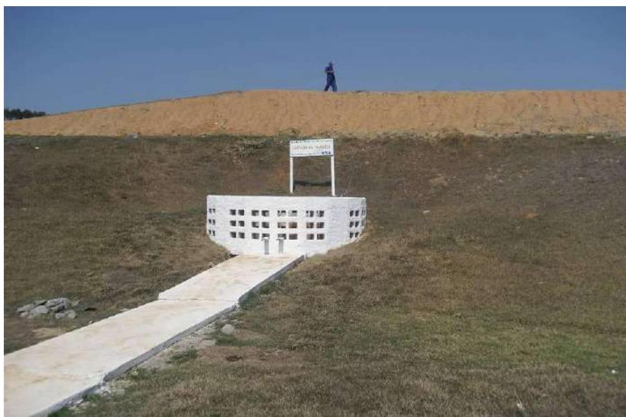
**Foto 09 - Poço de Captação de Líquido Percolado – Chorume.**
