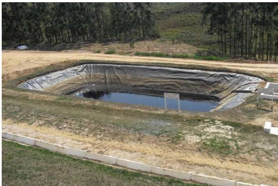
Foto 10 - Tanque Reservatório de Líquido Percolado – Chorume.
